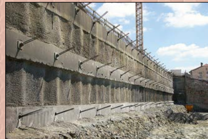
Pantalla pilotes anclada con cable
