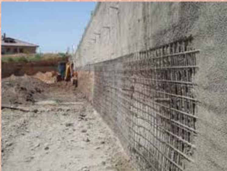
Ejecución Soil Nailing
