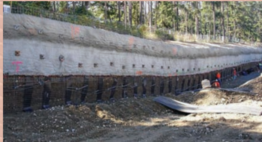
Contención con bulones autoperforantes
