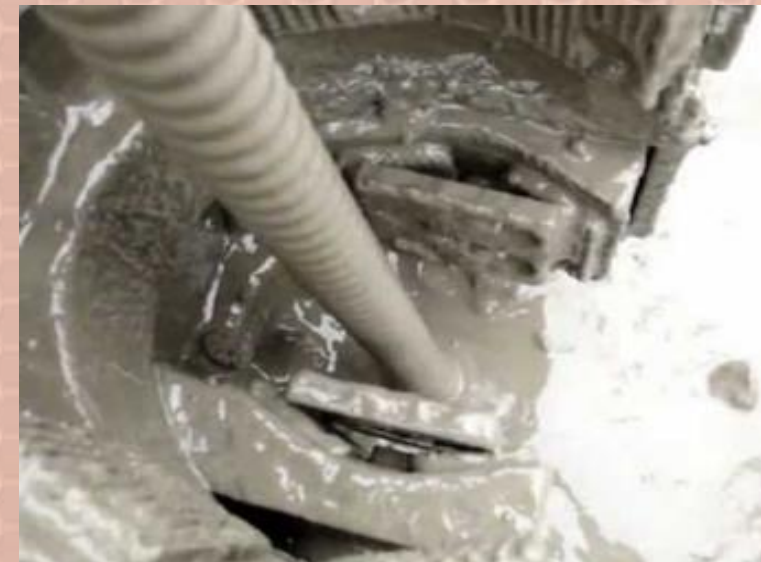
Ejecución Inyección Dinámica
